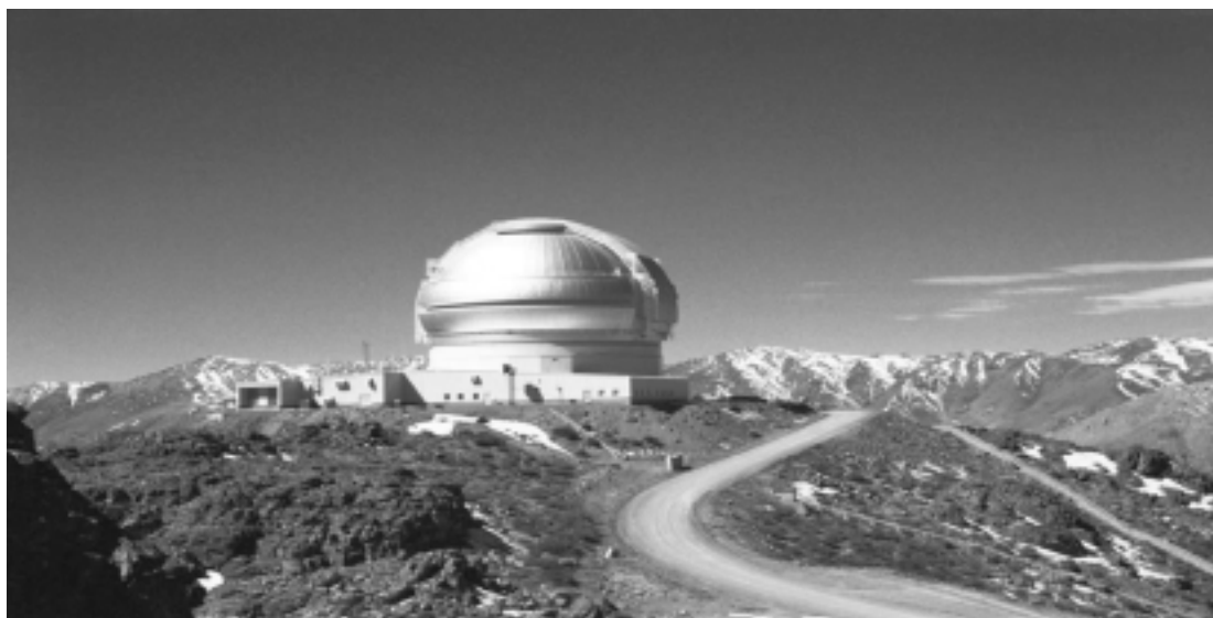
Observatorio Gemini-Sur, en Chile. En Astronomía se usa tecnología de punta, la que contrasta con los remotos lugares elegidos para instalar los telescopios. Los sitios son seleccionados con técnicas de sensoramiento remoto (satélites) y con trabajos de campo para determinar las condiciones atmosféricas y geofísicas del lugar.
